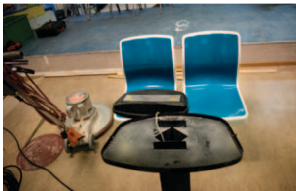
Renoveringsarbetet pågår för fullt.
